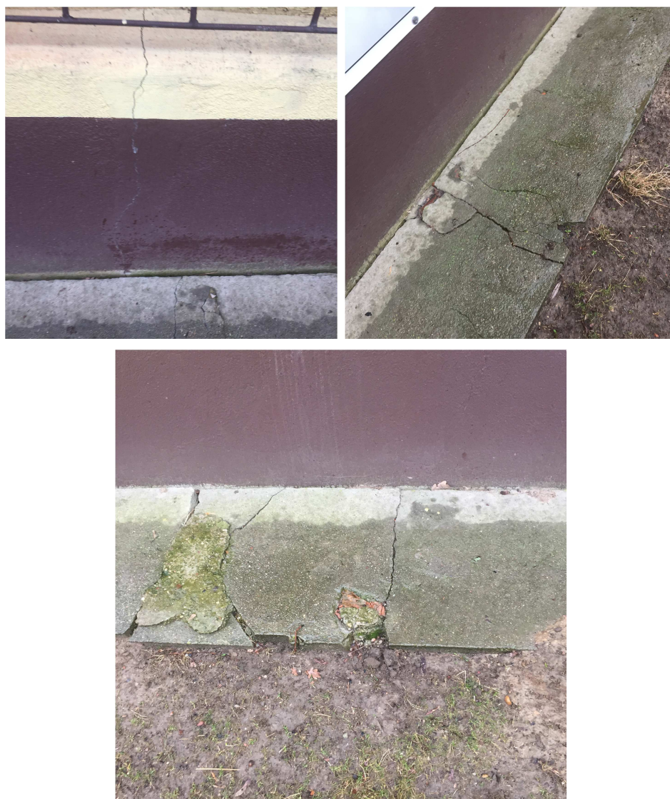
Fot. 1-3. Spękania fundamentów budynku głównego.
